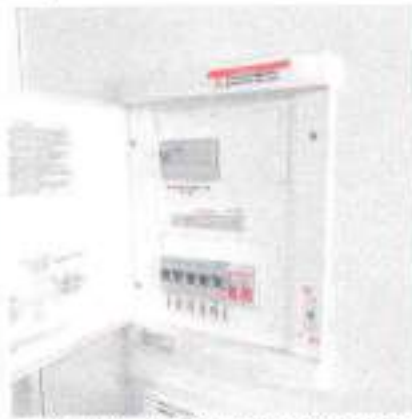
1.6 Quadro de disjuntores e distribuição
