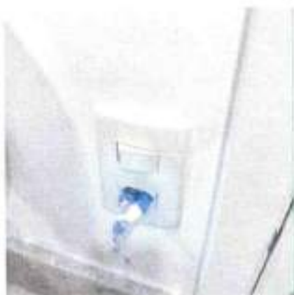
3.5 Tomadas e interruptores
